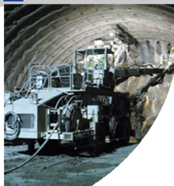
切羽計測 吹付け出来形計測
